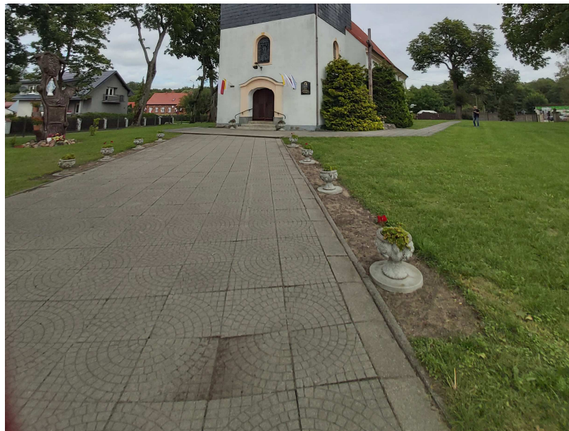
Zdjęcie nr 5: Utwardzenie od bramy do Kościoła – widoczne załamanie płytek
