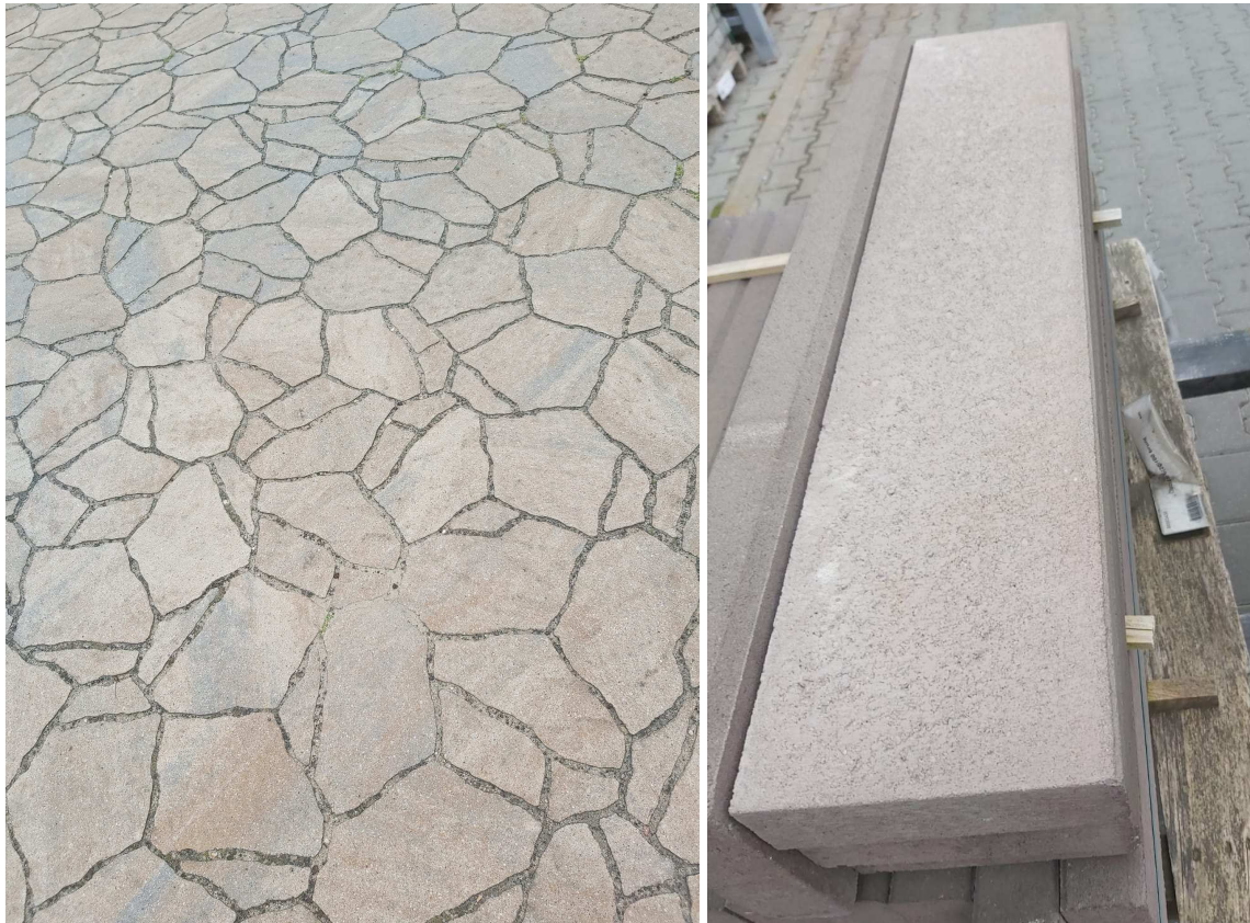
Zdjęcie nr 7: Wzór ułożenia utwardzenia oraz obrzeża chodnikowego
