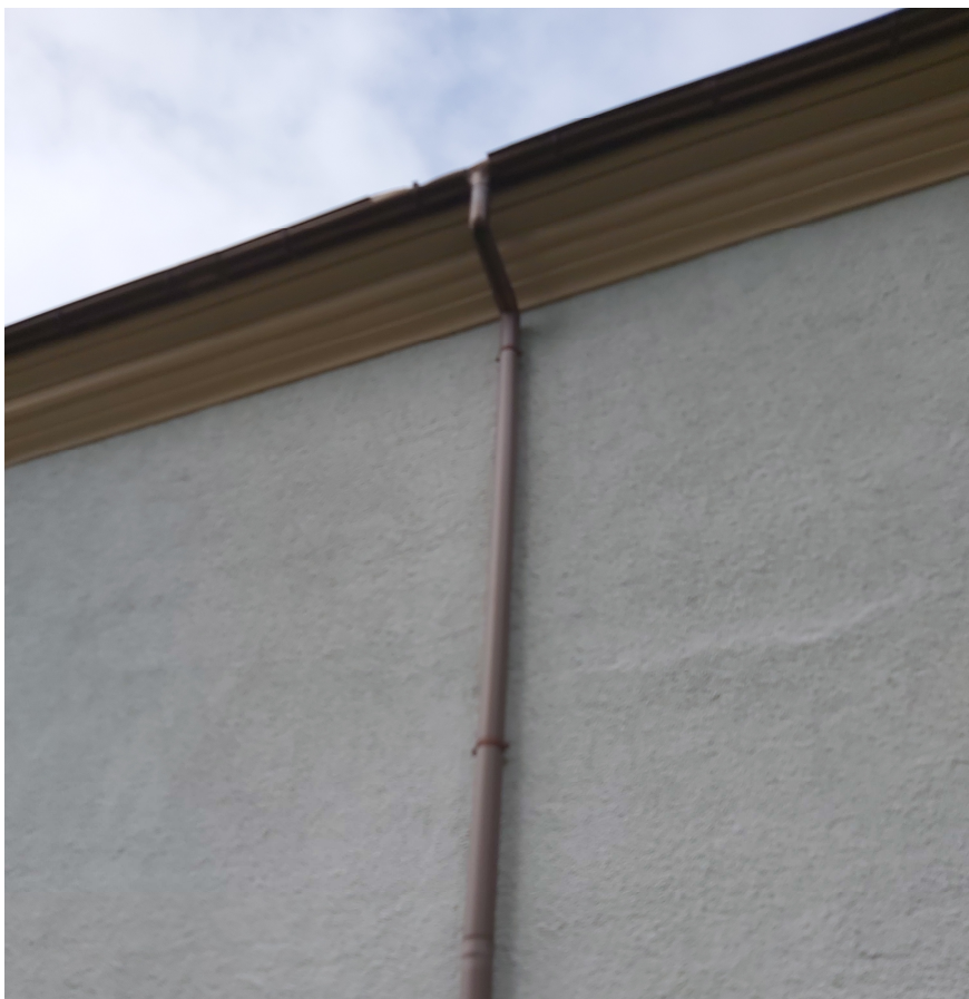
Zdjęcie nr 3: ubytki rynny w miejscu spływu wody do rury spustowej.
