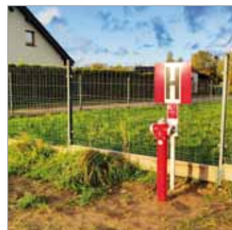
Kolejne posesje na nowym osiedlu zostały przyłączone do wodociągu.
